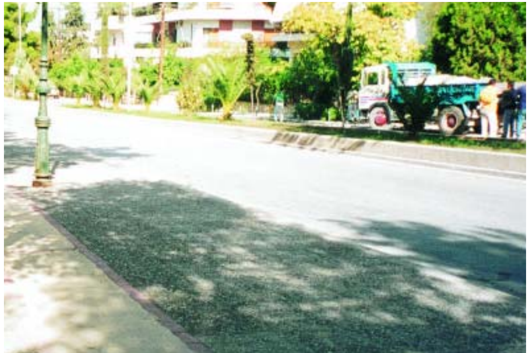
Φωτ. 6.1. Παπάγου. Αθήνα. Οδός Κύπρου. Ο δρόμος αυτός συνδέει τη λεωφόρο Μεσογείων με το εσωτερικό του δήμου. Αποσπασματικός διάδρομος επί του πεζοδρομίου που δεν είναι ξεκάθαρο αν απευθύνεται στον ποδηλάτη ή στον πεζό.
